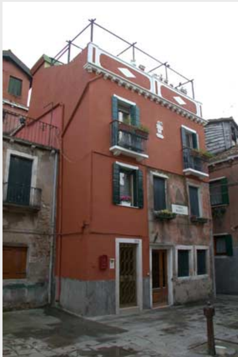
Fotografia generale dell'edificio: CS101082_G01
