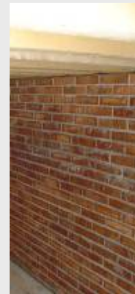
MATTONI PIENI, MALTA BASTARDA FACILMENTE RIMOVIBILE DAI GIUNTI
