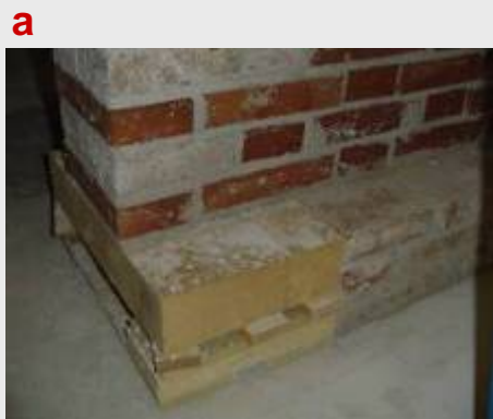
INSERIMENTO DI ZEPPE E SPEZZONI DI TRAVI IN LEGNO IN POSIZIONE CENTRALE E TERMINALE
