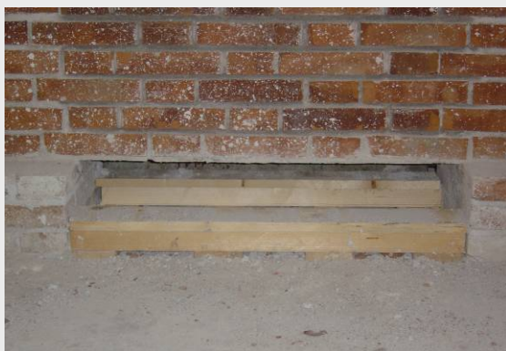
ELIMINAZIONE DELLE ZEPPE LIGNEE DI APPOGGIO DELLA FONDAZIONE
