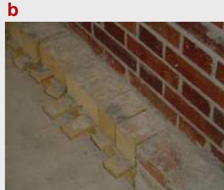
INSERIMENTO DI ZEPPE E SPEZZONI DI TRAVI IN LEGNO IN POSIZIONE CENTRALE E TERMINALE
