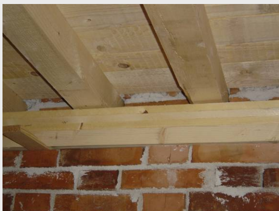
ELIMINAZIONE DELLE ZEPPE LIGNEE DI APPOGGIO DELLE DUE TRAVI CENTRALI DEL PRIMO SOLAIO
