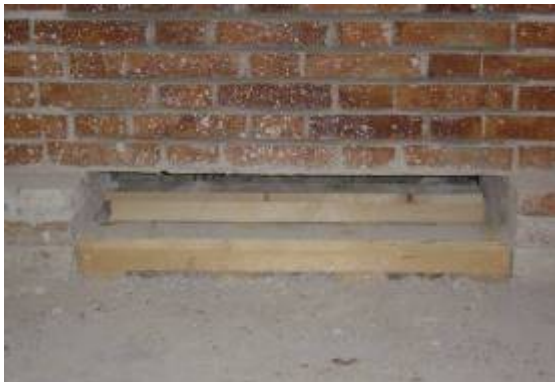
Eliminazione zeppe alla base del muro
