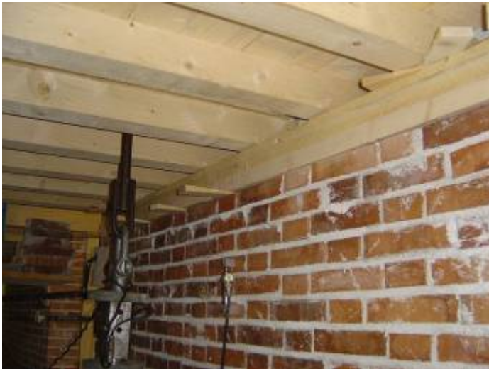
Carico concentrato di entità crescente (0-2000 kg) applicato mediante martinetto oleodinamico
