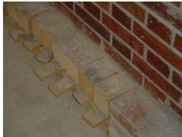
Particolare appoggio alla base di uno dei due setti
