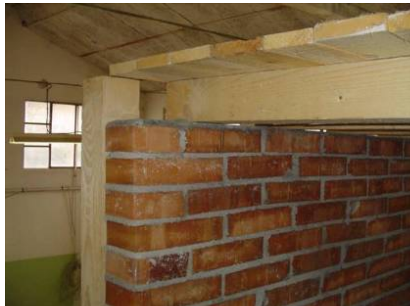
Particolare appoggio del secondo solaio
