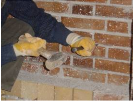
Scarnificazione giunti base del muro
