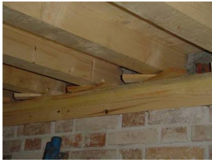
Particolare appoggio del primo solaio
