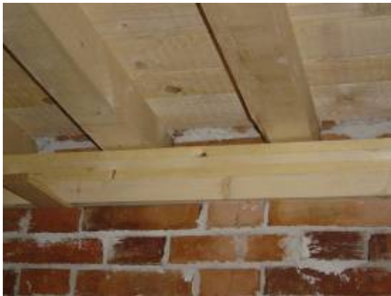
Eliminazione zeppe sotto trave primo solaio
